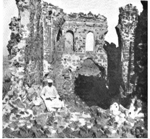
Resim 325: Saïd b. el-Âs kasrının kalıntılarındaki iki fotoğraf.
